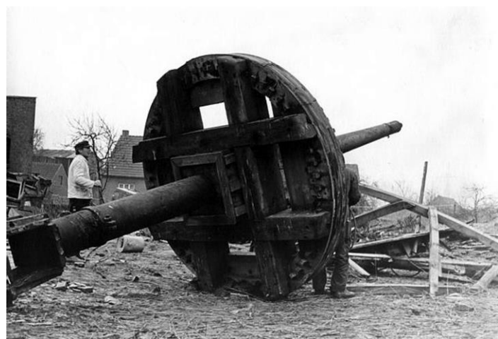
Die eiserne Mühlenachse und das Achsrad
